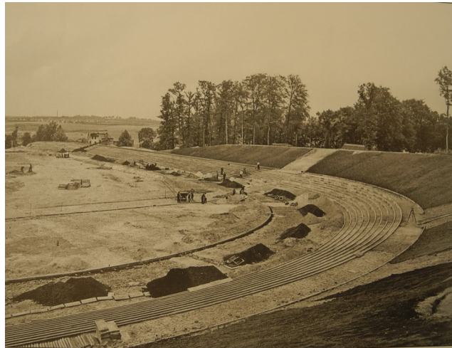
Im Bergedorfer Schießtal mit Arbeitslosenfürsorge-Empfängern der Bau des Bill-ns in Angriff genommen.
